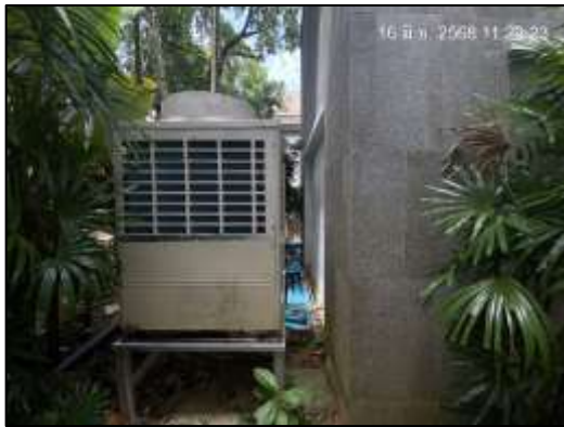
ระบบเครื่องปรับอากาศแบบ VRF
