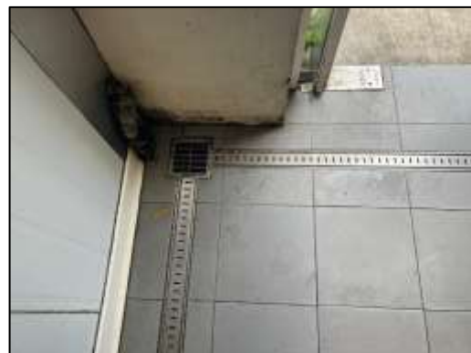
ท่อรับน้ำจากห้องพักขยะไปยังระบบบำบัดน้ำเสีย
